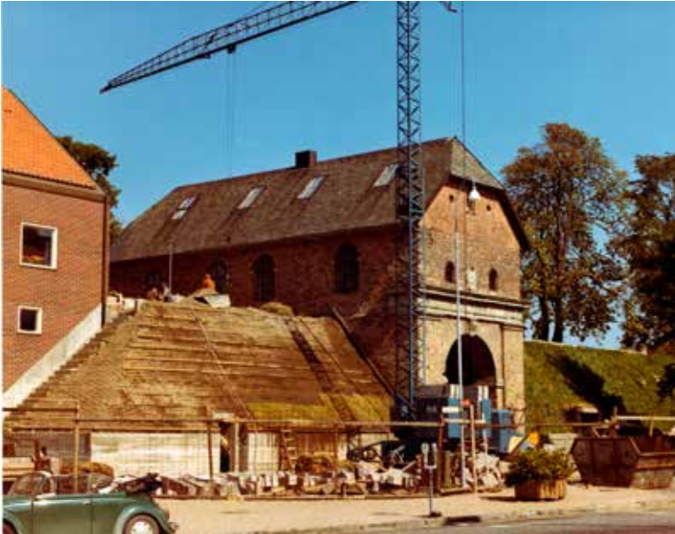
Figur 4. Rekonstruktion av vällen invid Norre Port. Foto: Stig Hartman, 1973.
