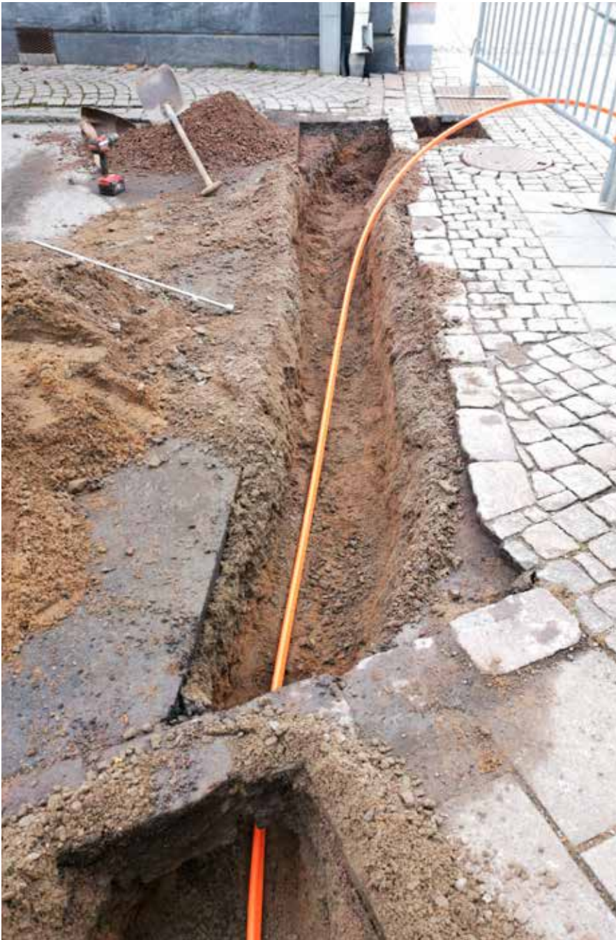
Figur 6. Schaktets södra halva när det är färdiggrävt och fiberledningen läggs. Endast recenta bärlager synligt i botten. Foto: Sofie Renström. (Fotonr. 2022-8-7).
